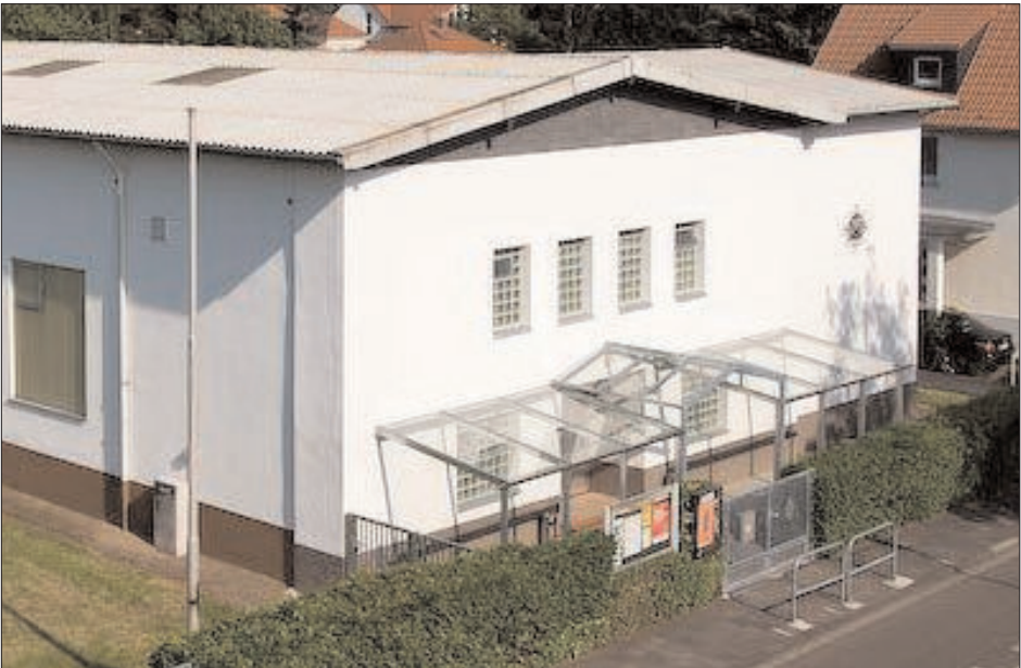
Ansicht Halleneingang nach der Sanierung
