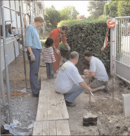
Ansicht Halleneingang während der Sanierungsarbeiten.
